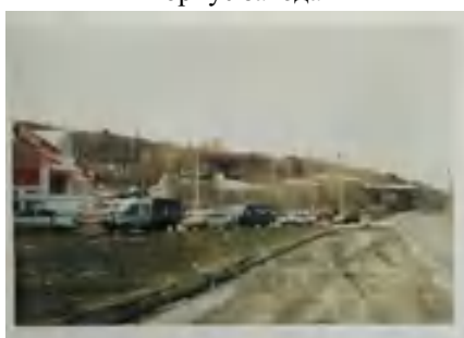
Т.Ф. 15. Вид в сторону комплекса Курбатовского завода с северо-востока, с улицы Красная Слобода
