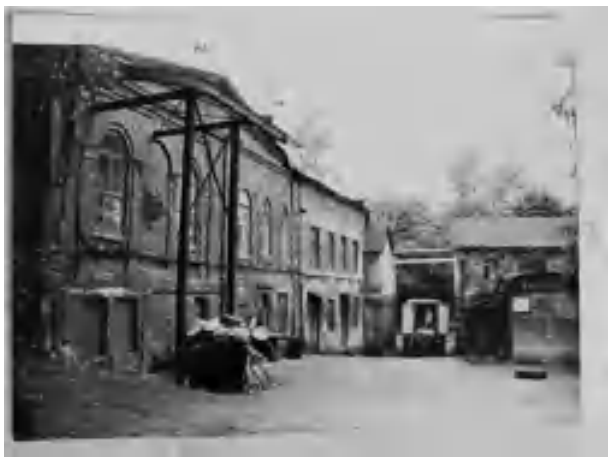
Вид с юго-восточной стороны, вид с дворовой территории
