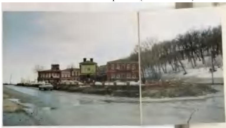
Т.Ф.8. Вид в сторону комплекса Курбатовского завода с северо-запада
