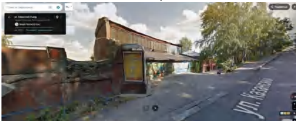
Общий вид с западной стороны с Казанский съезда.
