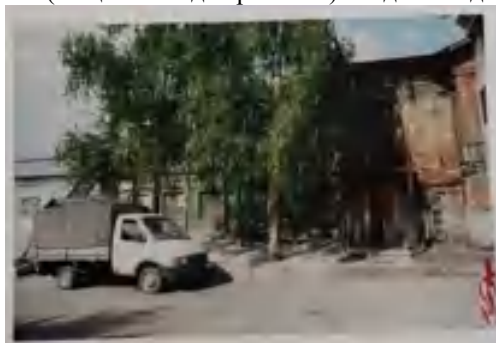
Северная линия застройки. Фрагменты дворовых корпусов под условными №№11,12,13. Вид с юго-востока
