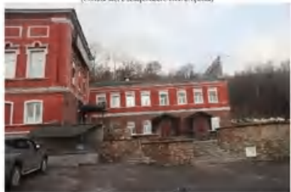
Точка фотофиксации № 2 (Общий вид с север-восточной стороны)
