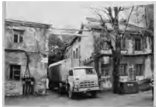
Вид с северо-западной стороны, с дворовой территории
