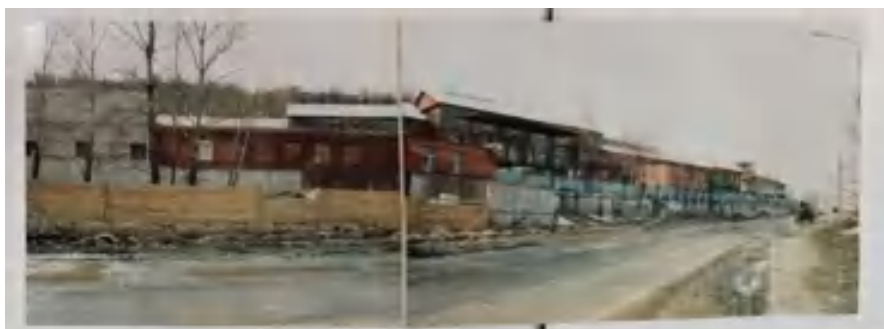
Т.Ф. 12. Вид на комплекс Курбатовского завода севера.
