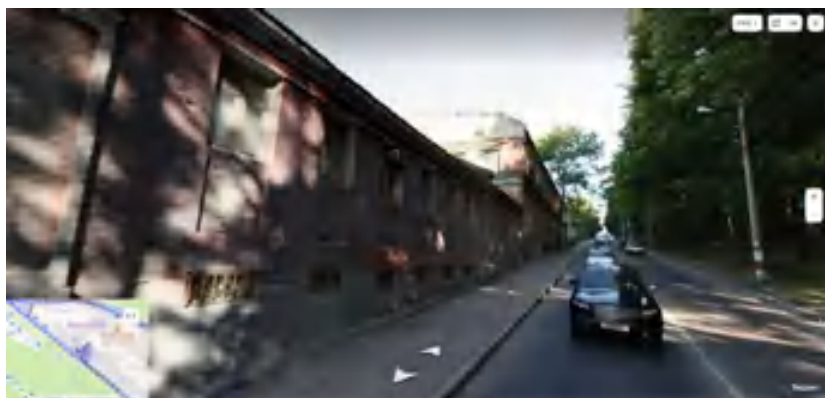
Общий вид с юго-восточной стороны с Казанского съезда.
