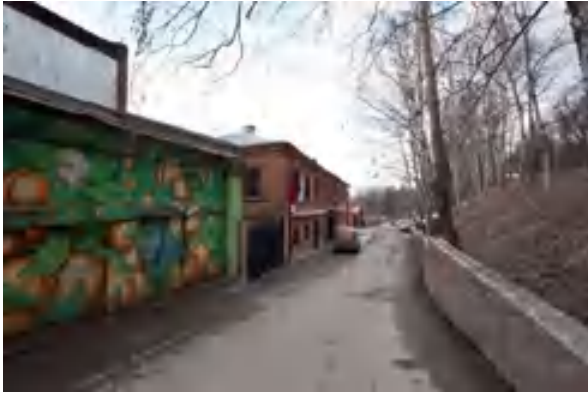
Общий вид с западной стороны с проездной дороги
