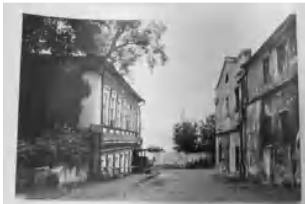
Вид с южной стороны, с дворовой территории
