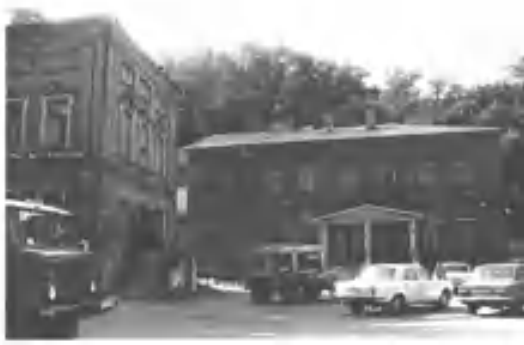
Вид с северо-восточной стороны с ул. Красная слобода.
