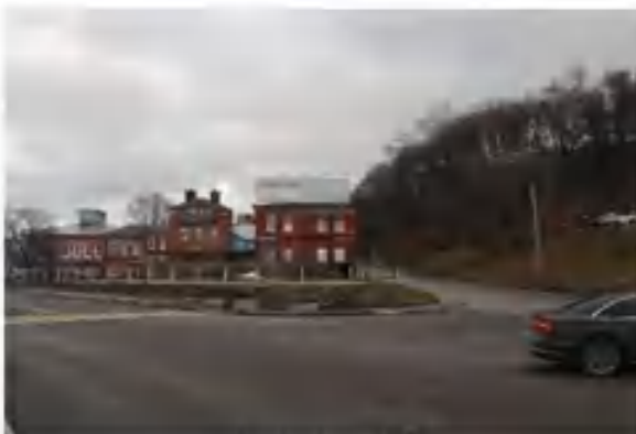
Точка фотофиксации № 1 (Общий вид с северо-западной стороны)
