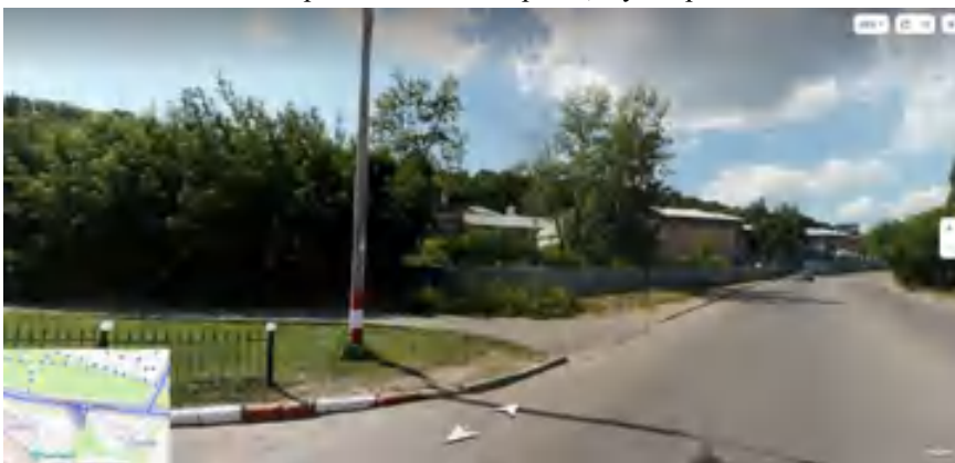
Общий вид с северо-восточной стороны, с ул. Красная Слобода.
